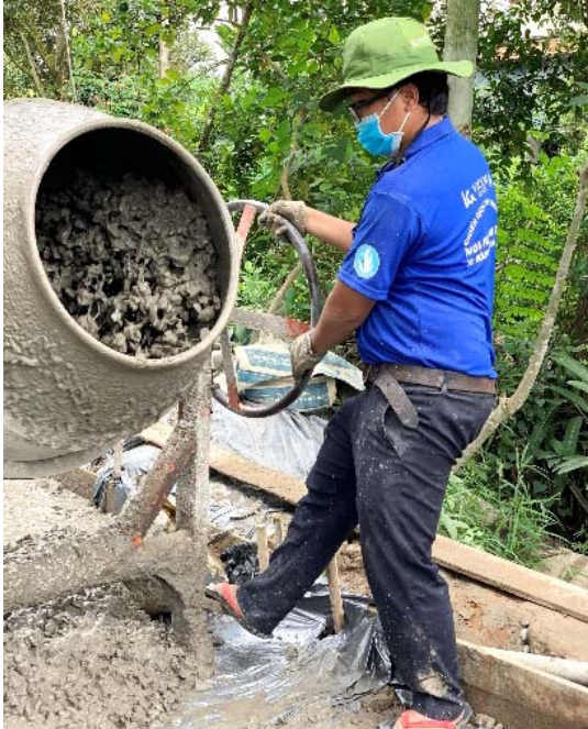
TS Lê Thanh Long tham gia làm đường nông thôn trong hoạt động Mùa hè xanh của Trường ĐH Bách Khoa tại xã Hưng Khánh Trung B, huyện Chợ Lách, tỉnh Bến Tre. Ảnh: NVCC
